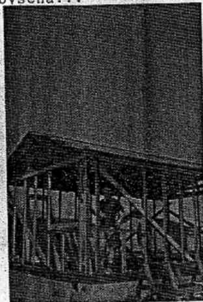
...och byggde en sån här fin stomme.
