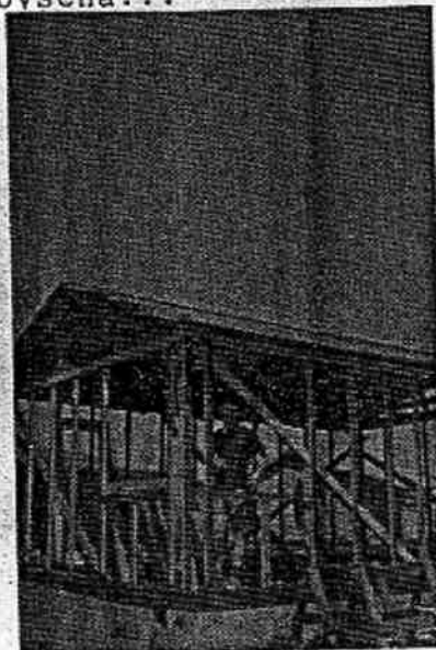
...och byggde en sån här fin stomme.
